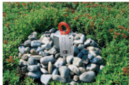
Cada Fallnet® SR é fornecido com uma marca de identificação localizada no ponto de ancoragem. Esta marca indica o nome do produto, o padrão de teste, a data de produção do módulo e o número de série do módulo. Essas informações permitem identificar que se trata de um dispositivo de linha de vida.
