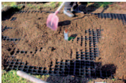
Graças à estrutura em colmeia dos elementos modulares, o substrato esconde perfeitamente o Fallnet® SR, colocado diretamente na camada de filtro.
