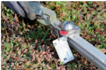
Com a âncora linear montada horizontalmente, todo o raio de movimento em torno do anel de deslizamento pode ser utilizado. É um sistema muito eficaz para ser usado em superfícies estreitas da cobertura.
