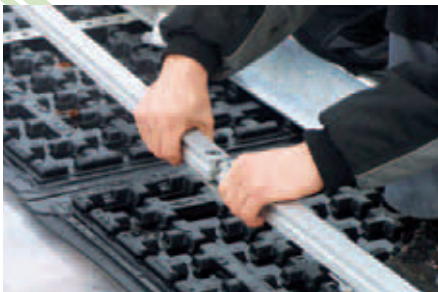
O sistema modular permite a combinação do sistema linhas de vida com a base solar ZinCo.
