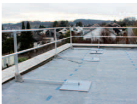
Módulos de postes antes de aplicar o sistema da cobertura verde.
