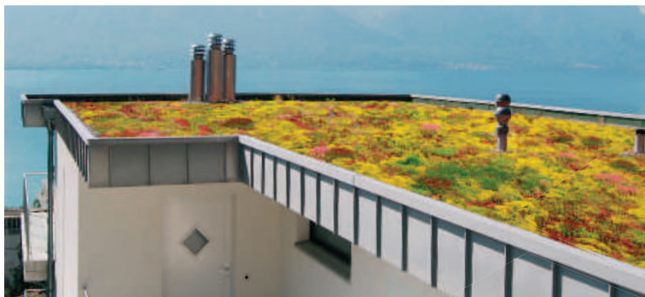
Coberturas Verdes extensivas
