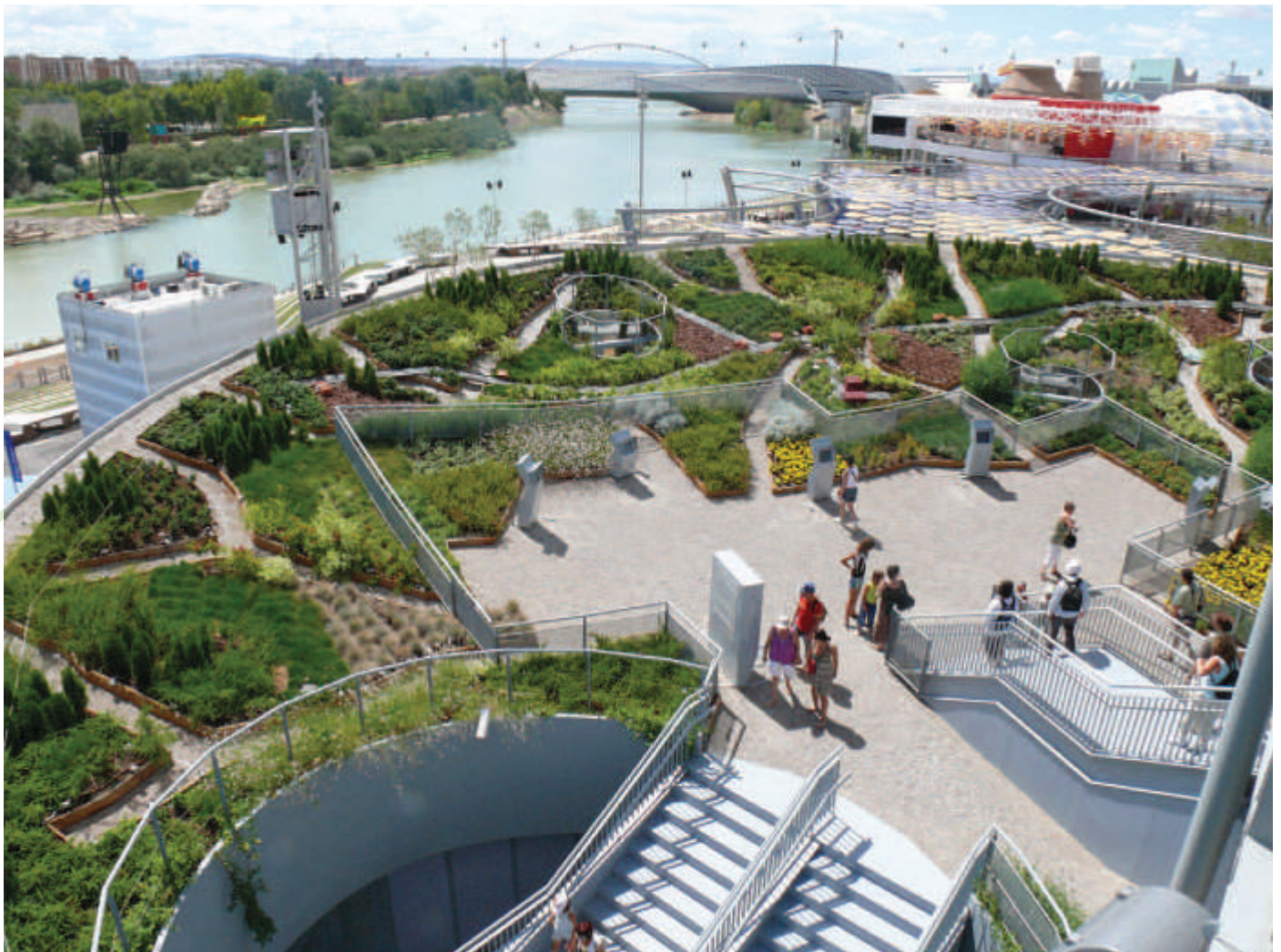
Coberturas Ajardinadas na EXPO, Saragoça
